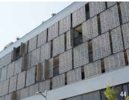
Wirksamer, gut hinterlüfteter außenliegender Sonnenschutz
