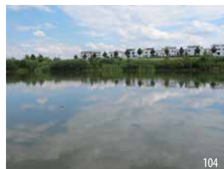
Retentionsanlage als Naherholungsziel
