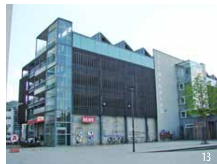
Supermarkt, Parkhaus und Energiegewinnung auf einem Grundstück
