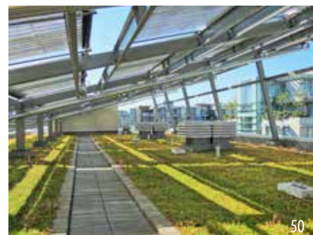
Solarthermie effektiv kombiniert mit extensiver Dachbegrünung
