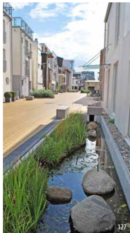
Retentionsbodenfilter im Wohnquartier
