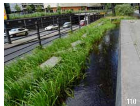
Regenwasseranlage über einer Verkehrsachse
