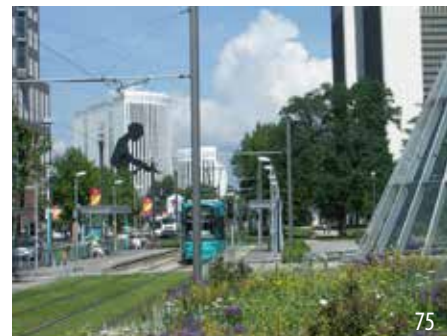
Rasengleis und Grünanlage an der Messe Frankfurt
