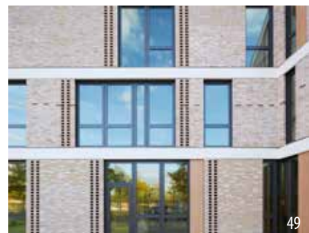
Passivhausbau im Schulbereich
