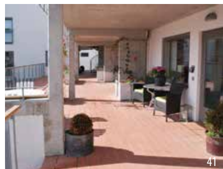
Effizient gehaltene Gebäudehülle mit erschließendem Laubengang
