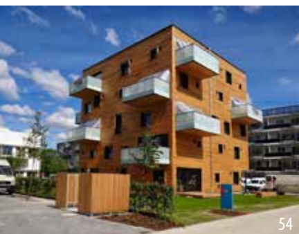
Fünfgeschossiges Wohnhaus in fast vollständiger Holzbauweise
