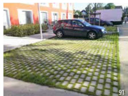
Begrünte, versickerungsfähige Befestigungsmaterialien im Stellplatzbereich
