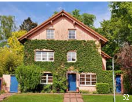
Fassadenbegrünung im Bestand
