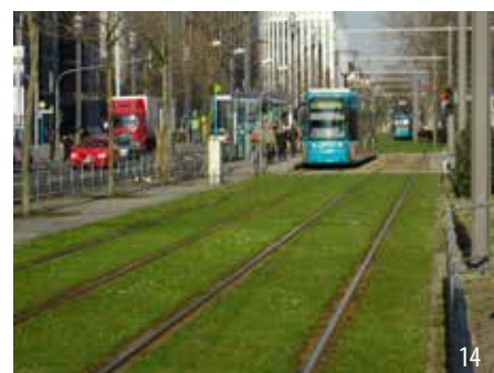
Begrünte Gleisanlagen zur innerstädtischen Kaltluftförderung
