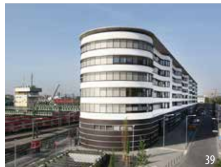
Zertifiziertes Gebäude des Grünflächenamtes
